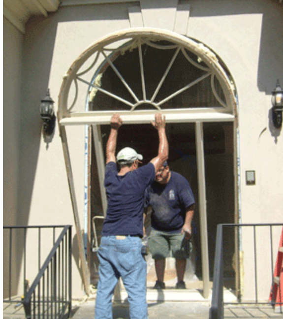
7. Remove old door frame
